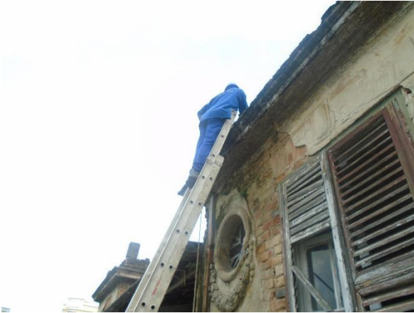
Obras emergenciais na cobertura do palacete (bloco 1)
