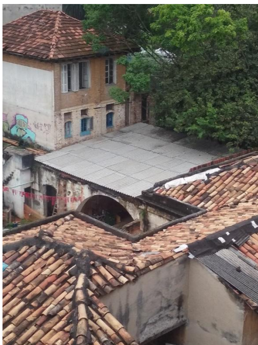
Execução de cobertura protetora para laje do bloco 8
