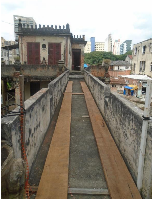
Obras emergenciais no palacete (bloco1)
